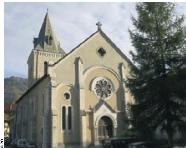
Eglise Saint Laurent d'Ugine.
